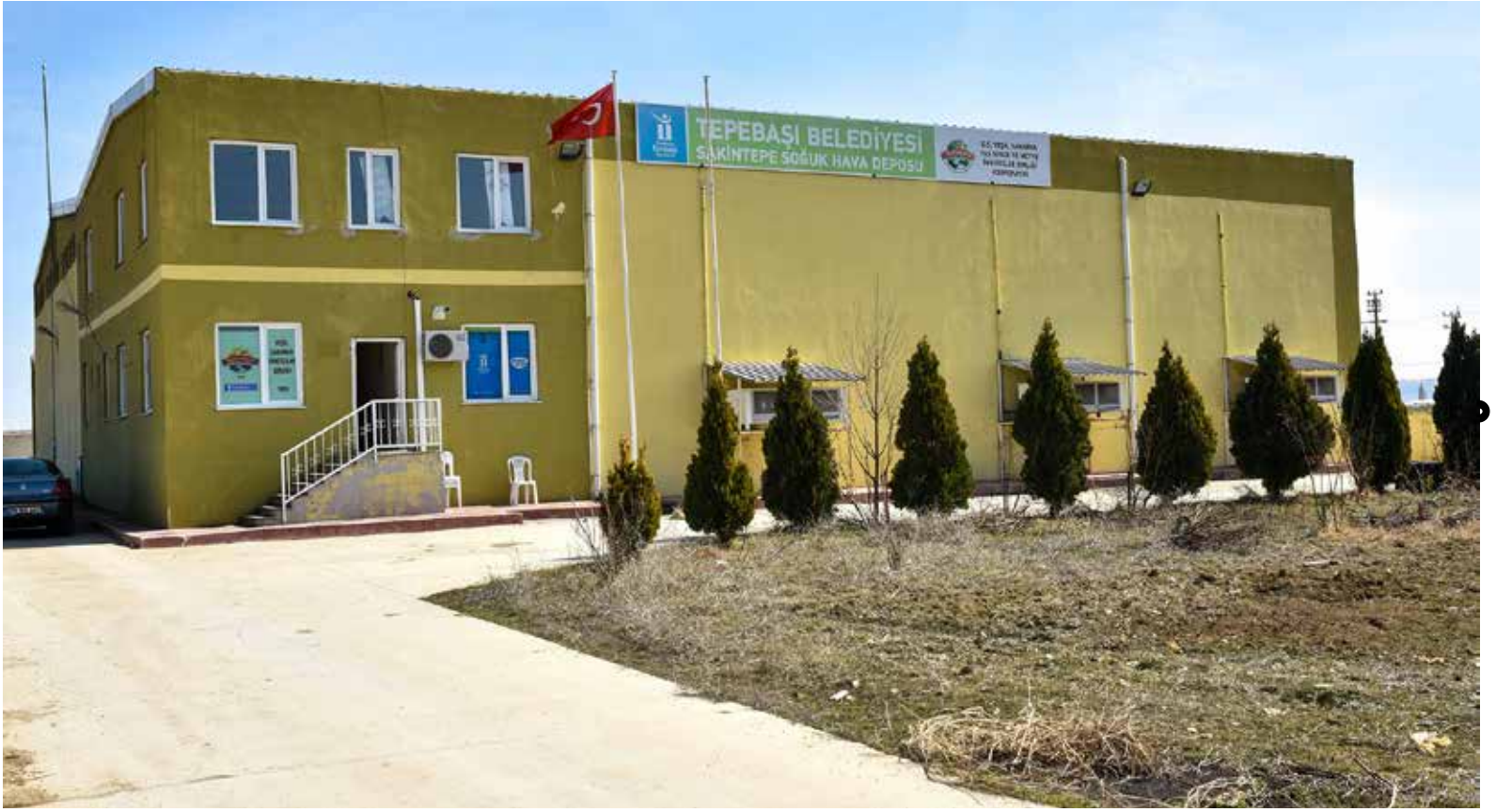
Cold Storage | SOĞUK HAVA DEPOSU
